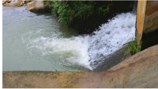
重点避开 4: 河道中有急流出水口处
